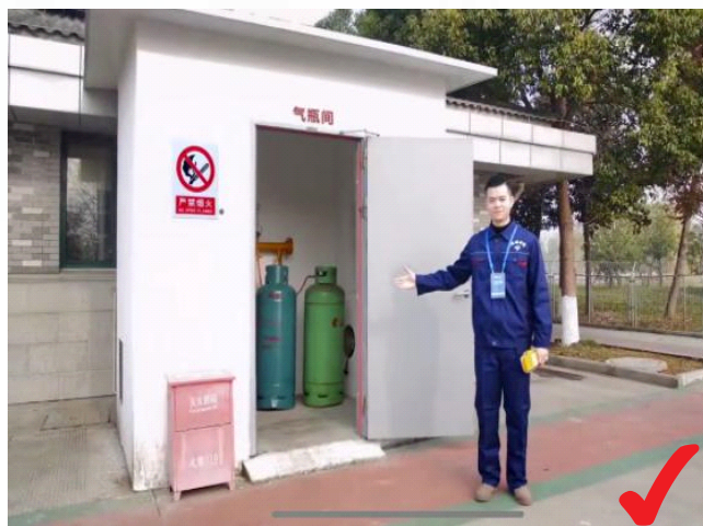
气瓶总重量超过规定数值的设置专用气瓶间
