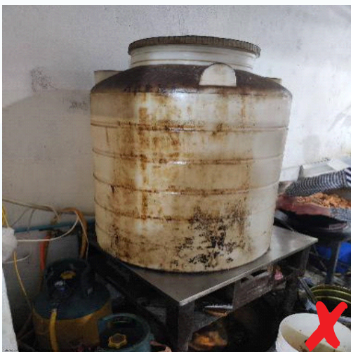
同一房间内违规使用两种燃料 (液化石油气和醇基燃料)
