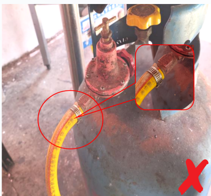
严禁使用橡胶软管， 采用承插式卡箍固定
